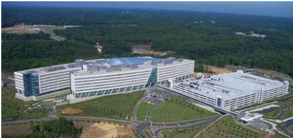
NGA East Campus, Fort Belvoir
