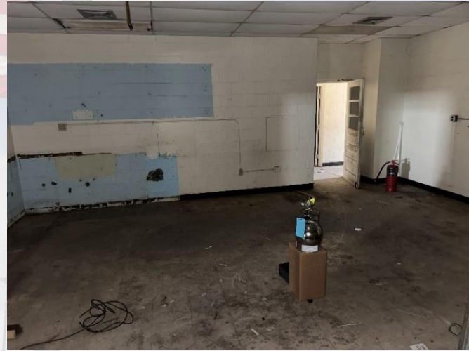
Site 31 TCRA Vapor Intrusion Sampling
